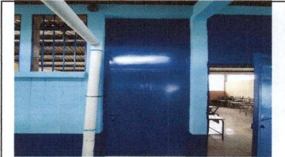
FOTO 3: Mantenimiento a estructura (lijado, cambio de tubo , cepillado, sujetiones, aplicación de pintura) Puertas en aula
