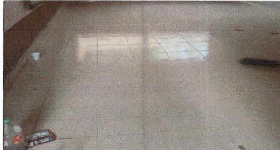
FOTO 6: Sustitución de piso liso por piso cerámico. En aula
