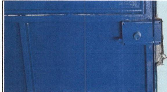
FOTO 4: Sustitución de Chapa A Puertas en modulo de aulas
