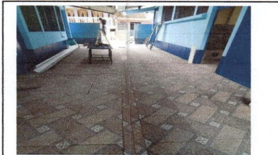
FOTO 10: Sustrución de piso liso por piso cerámico
